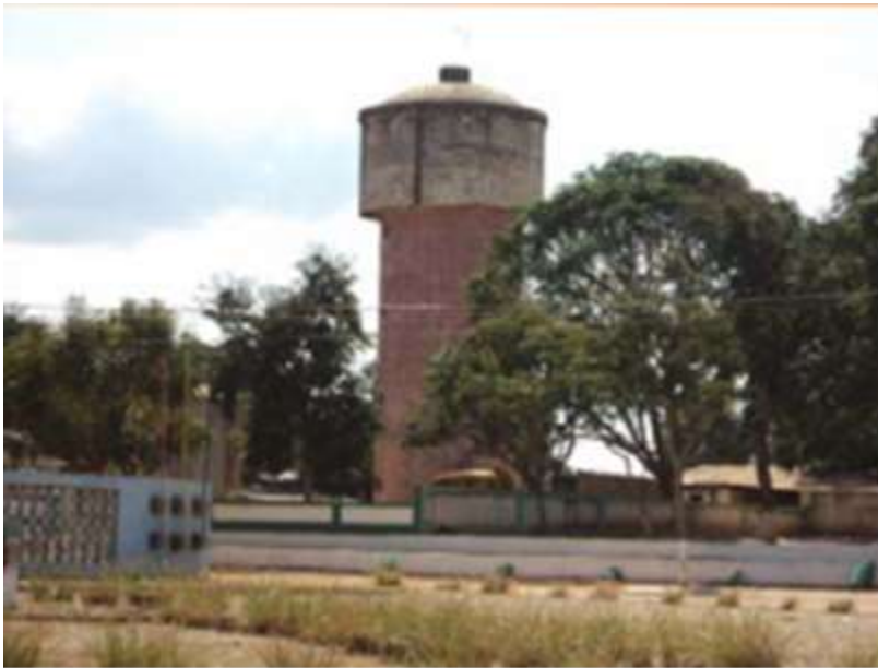
FIGURA 19: DEPÓSITO ELEVADO DE 50 M3 EM UTILIZAÇÃO NO NOVO SISTEMA
