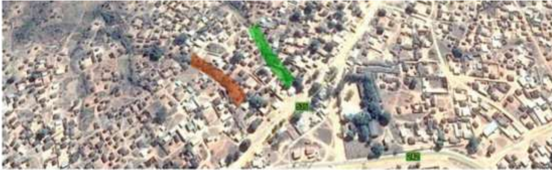
Figura XX – Identificação de zonas em processo de erosão na vila Fonte: 'Combate à erosão no bairro de Cafezeiro, Esplendor (2017)
