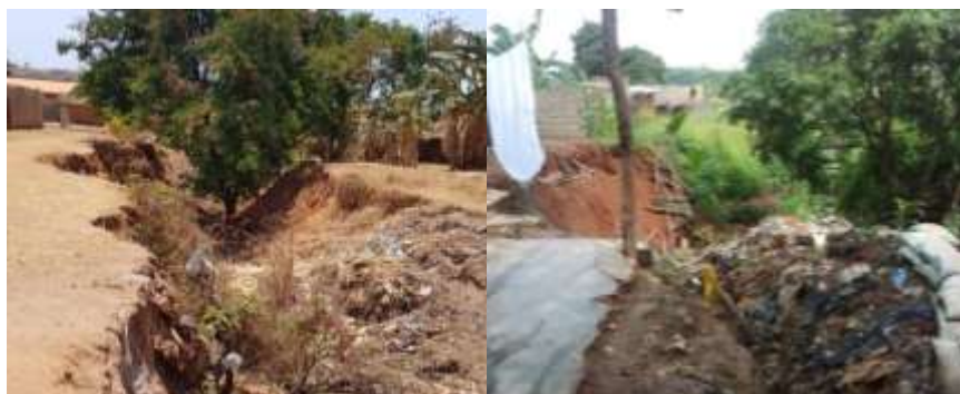
FIGURA 11: LOCAIS COM OCORRÊNCIA DE EROSÃO NO BAIRRO CAFEZEIRO
