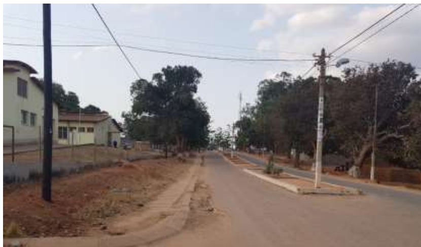
FIGURA 26: VALA DE DRENAGEM REVESTIDA E COM COBERTURA
