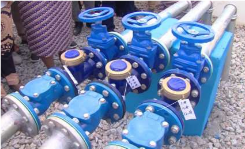
FIGURA 21 NOVO SISTEMA DE ABASTECIMENTO DE ÁGUA CONSTRUÍDO EM MARRUPA (2019)
